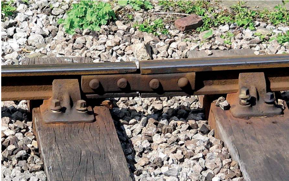
Figura 5: Huecos en las vías del tren
